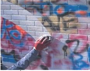
شكل (٣٦) سهولة تنظيف الجرافيتي من الأسطح المعالجة بالنانو ٣-٣-٥ الطلاء المضاد لبصمات الأصابع Anti-fingerprint
