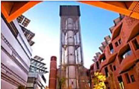
شكل (١٢) يقوم برج الرياح في مدينة مصدر بالتقاط نسيمات الرياح وتبريدها وتمريدها نحو الأسفل مما يخلق أجواء منعشة ومريحة
